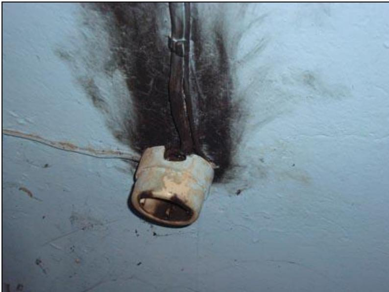
Figure 3 - Tomada danificada pela oscilação de energia eléctrica no CMC de Catandica
